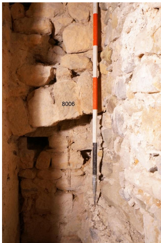
Figura 21. L'arco USM 8006, in parte obliterato da murature più tarde, in rapporto strutturale con il perimetrale nord dell'edificio di culto (a sinistra).
