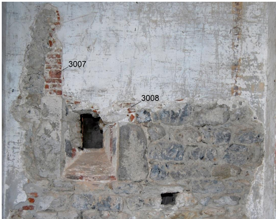
Figura 30. Ripresa in laterizi degli stipiti della monofora EA2.
