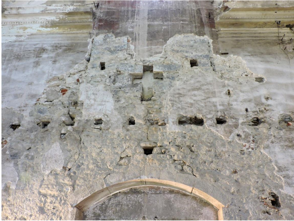
Figura 12. Controfacciata (PGA): particolare della croce lucifera e della muratura in conci squadrati relativa al campanile a vela.
