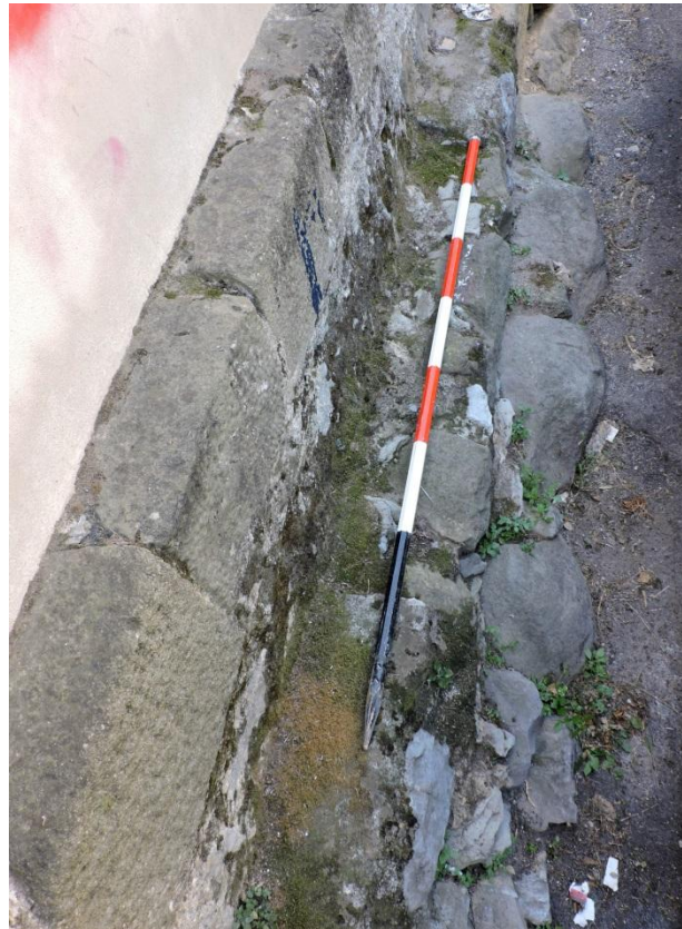
Figura 16. Il filare in conci di arenaria USM 7004 e le sottostanti riseghe di fondazione in ciottoli USM 7002 e 7001.
