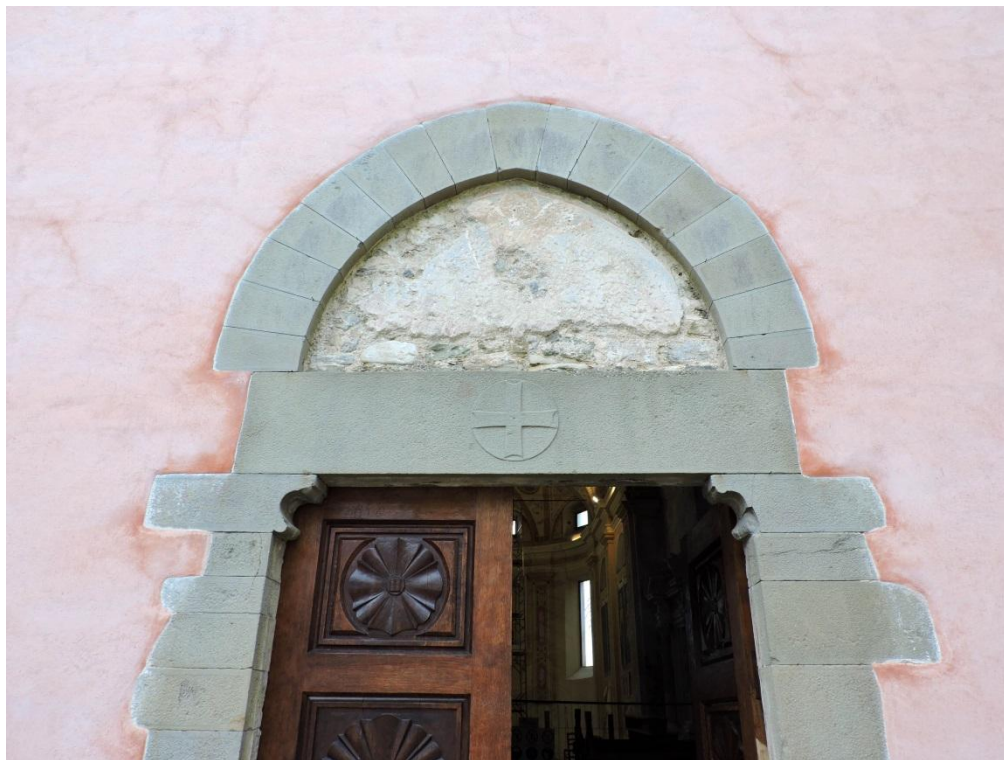
Figura 32. Particolare del portale di accesso alla navata.
