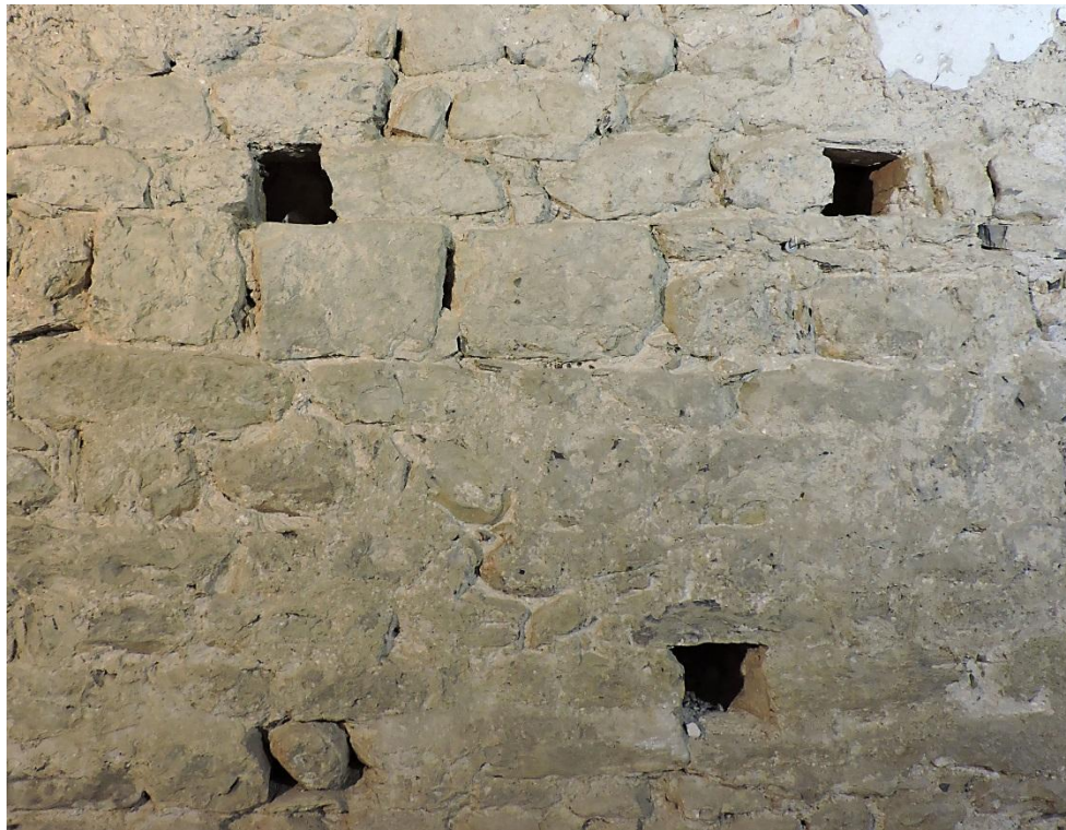
Figura 6. USM 2029, particolare della posa in opera.
