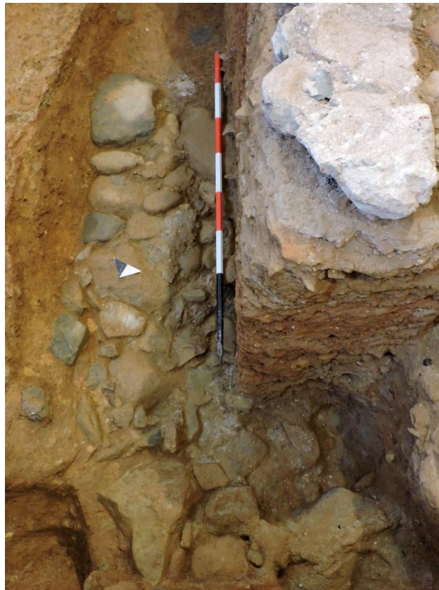
Figura 9. La tecnica costruttiva in ciottoli della fondazione USM 1052.
