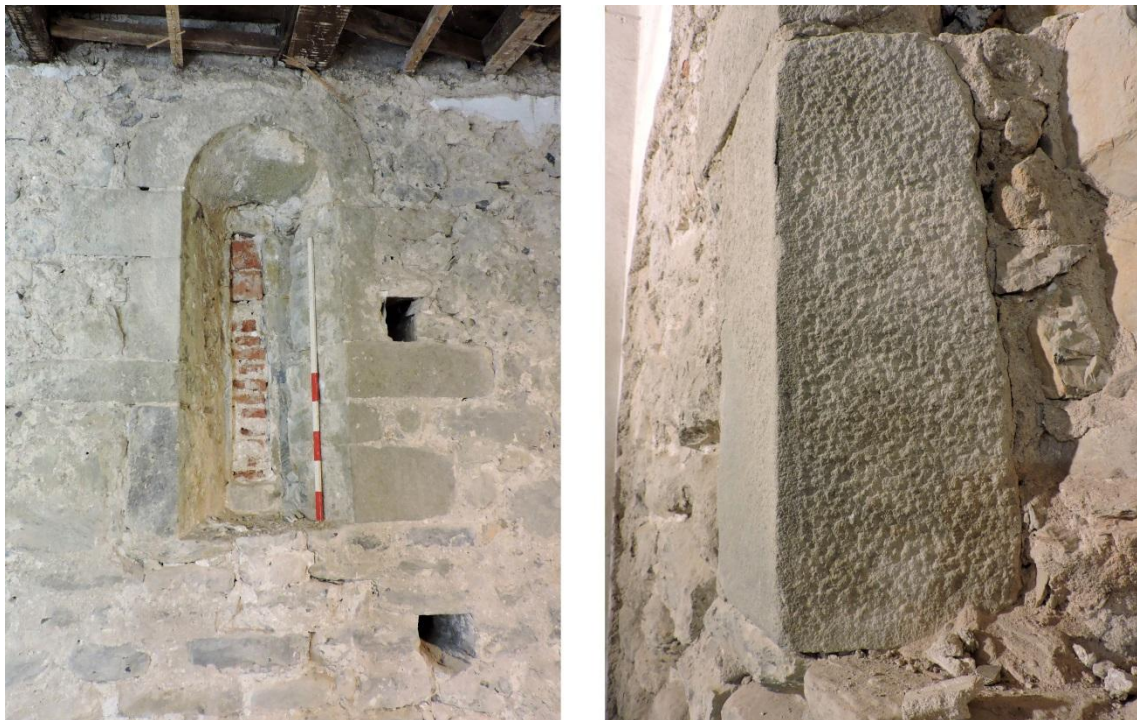
Figura 7. La monofora EA1 ancora leggibile sul perimetrale sud (PPI).
