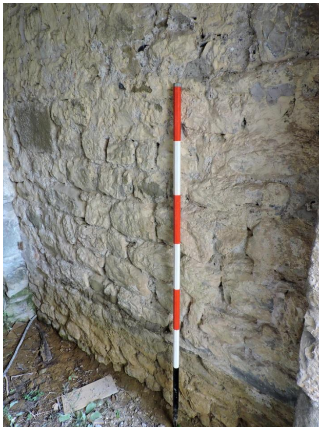
Figura 22. PPIX: il setto murario USM 8007, posto a chiudere lo spazio tra i pilastri USM 8001 e 8005, corrispondente al varco individuato dall'arco ogivale EA10.
