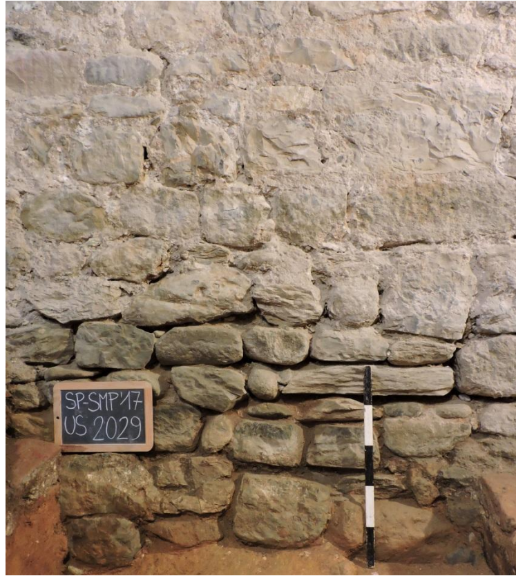
Figura 5. Particolare della tessitura muraria del paramento USM 2029, con la sottostante fondazione USM 2022.
