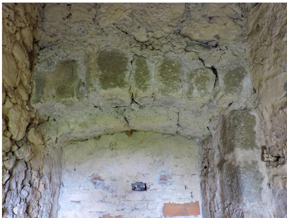
Figura 20. Particolare dell'arco ribassato USM 8006, verosimilmente in fase con il pilastro USM 8005.
